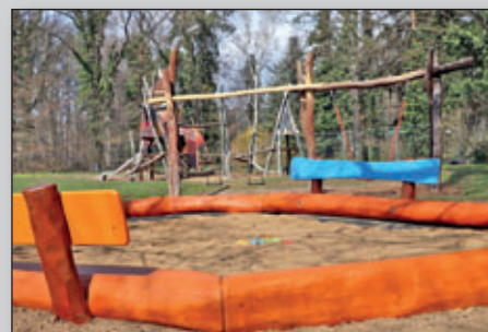
Auf dem Spielplatz an der Friedhofstraße beendete die Firma Holzgestalten aus Ostritz inzwischen die Arbeiten an der Schaukelkombination und der Sandkasteneinfriedung.
